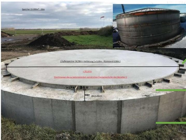
**Aufkantung**, damit kein Wasser unter den Stahlboden laufen kann (Durchmesser 34,58m)...
